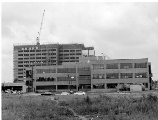
建設中の筑波大学附属病院旧棟。現在の追越看護 宿舎3号棟あたりから見た風景。
