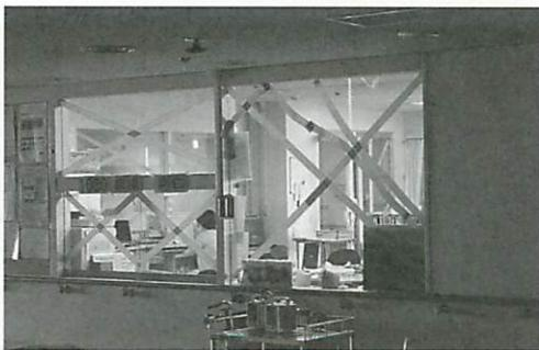
余震に備えて補強した窓ガラス（ナース・ステーション）
